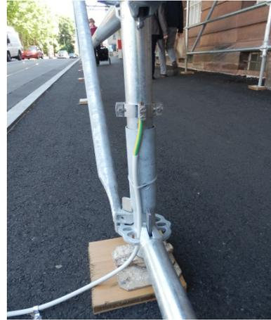
Abb. 1 Bahnerdung fest installiert
