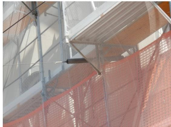
Abb. 7 Abspannung Schützen
